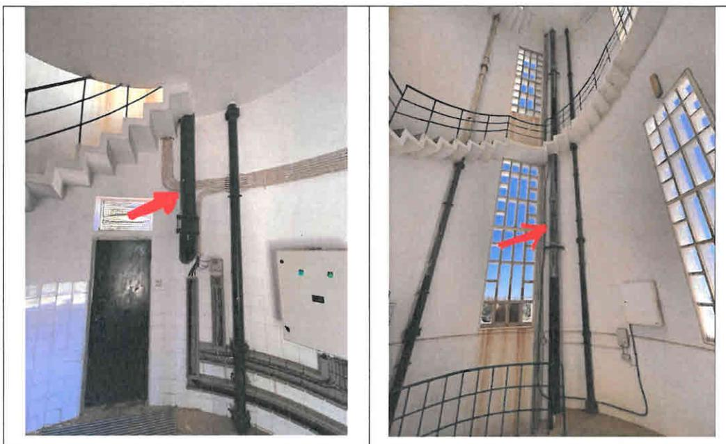
25. A fixação é para efetuar na parede interior. O diâmetro nominal da conduta é de 150 mm.-----
