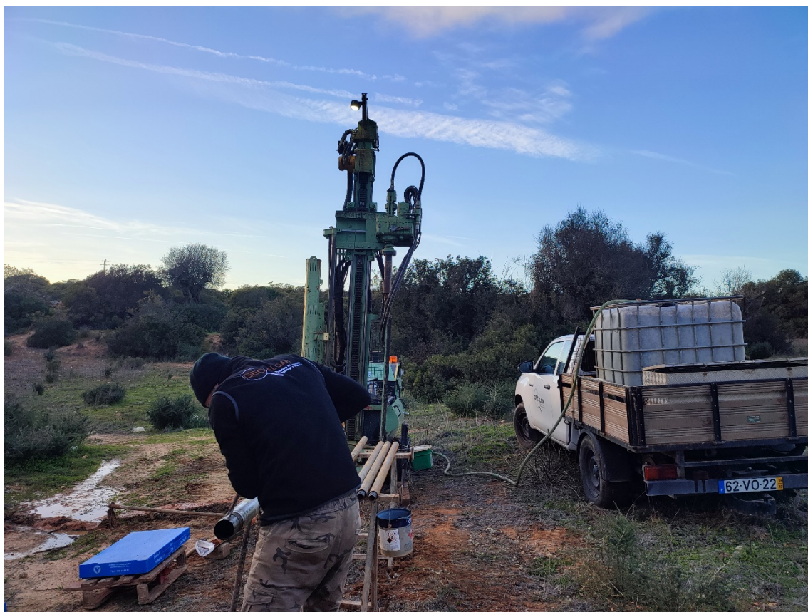
Figura 6.1 - Equipamento utilizado na furação, posicionado na sondagem SR05.
