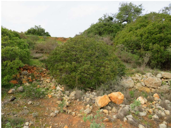
Figura 11. Vale de Engenho 4. Muro de contenção de talude.
