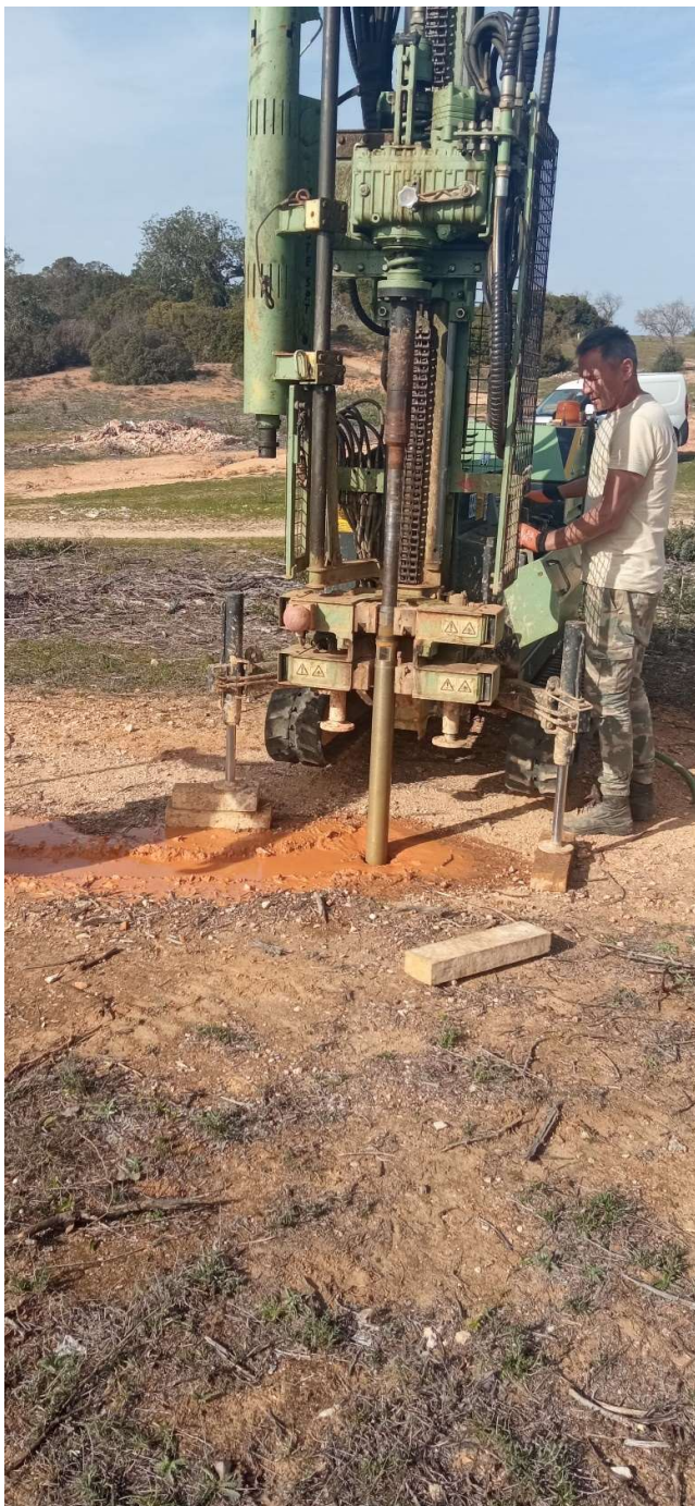
Figura 71. Equipamento de perfuração geotécnica.
