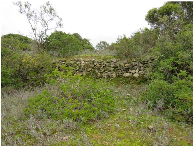
Figura 85. Ocorrência 11: Vale de Engenho 6.
