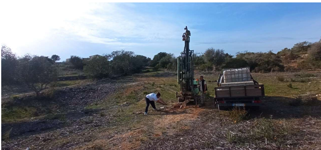
Figura 72. Trabalhos de perfuração geotécnica.
