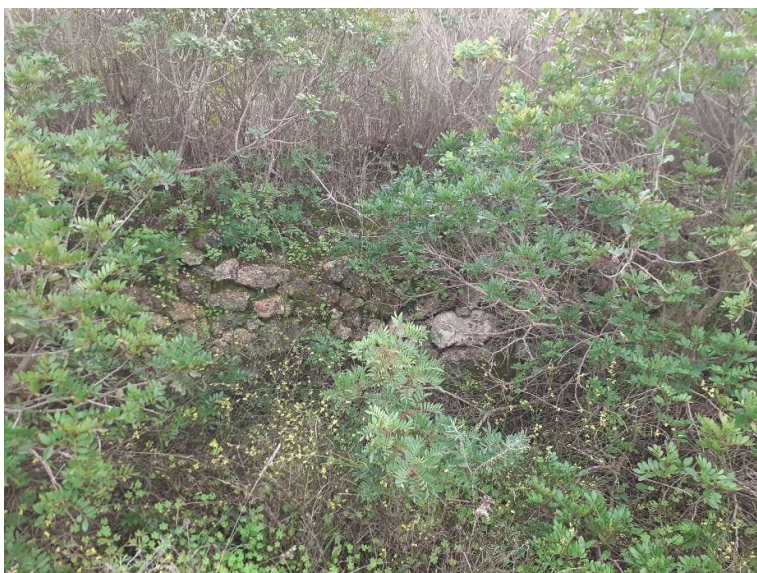
Figura 8. Vale de Engenho 2. Muro de contenção de talude.
