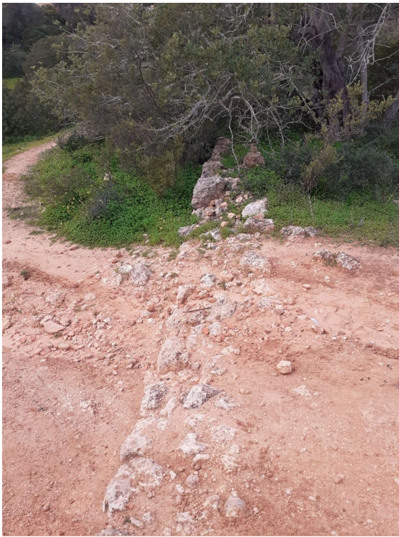
Figura 9. Vale de Engenho 3. Muro de demarcação de terreno.
