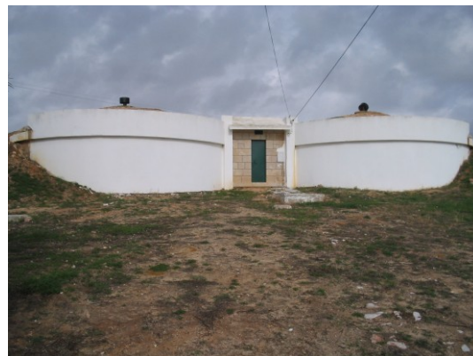
Figura 20 - Reservatórios do Cerro Gordo
